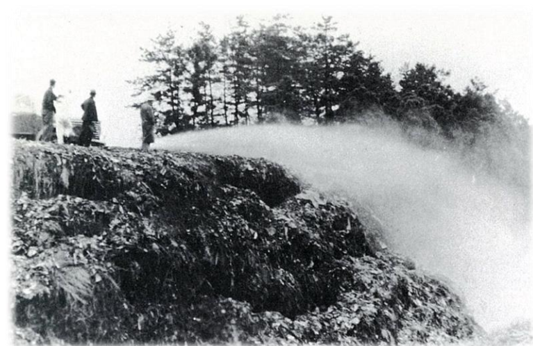
Pulvérisation du désinfectant au site de traitement
