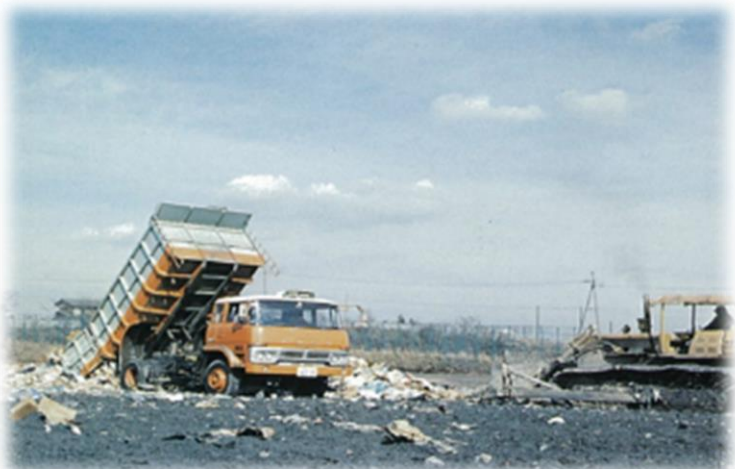
Remblayage des cendres d'incinération
